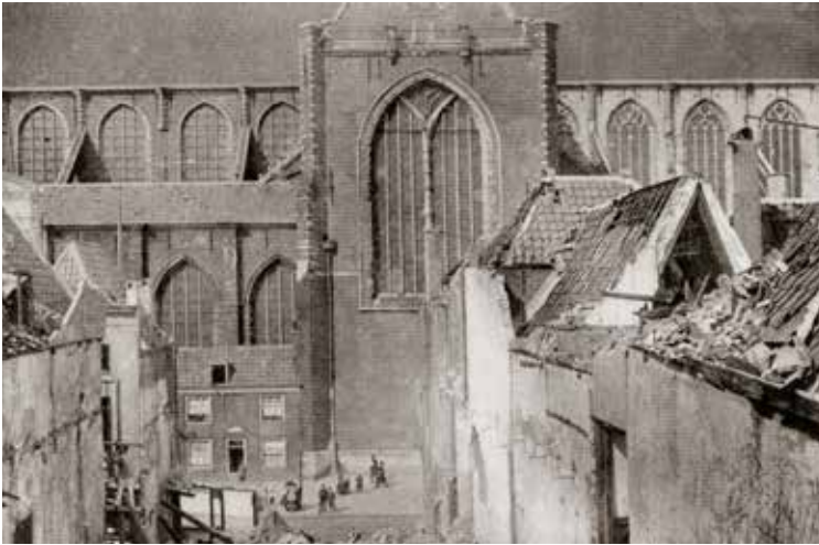
De montants en traceringen van het koor (rechts) zijn aangebracht. Later zullen de ramen van het middenschip (links) worden vernieuwd.
