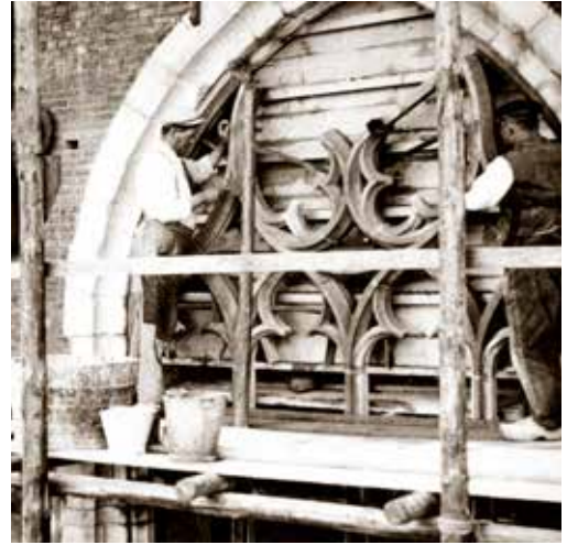
Metselaars zetten delen van de natuurstenen tracering op hun plaats.
